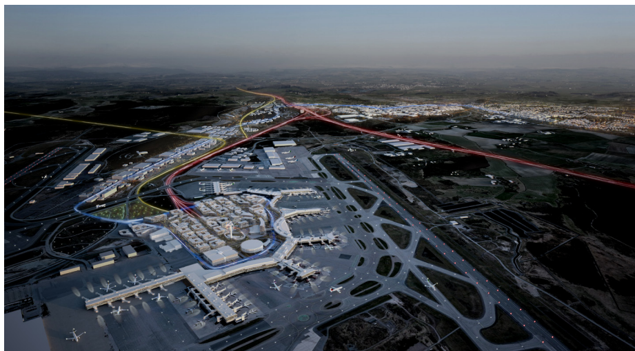
Till år 2040 ska bland annat en ny pir byggas till på terminal 5.
