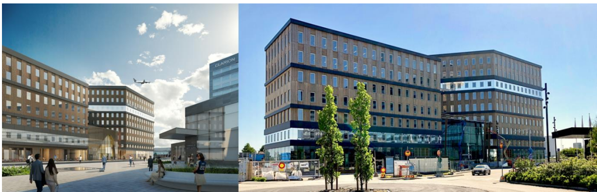
Den terminalnära byggnaden SkyCity Office One erbjuder flexibla mötesplatser vid Stockholm Arlanda Airport. Till vänster visionsbild. Foto Sandellsandberg. Till höger dagens utseende (2018-05-24) Foto Hans Uhrus, Swedavia.
