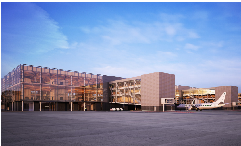
Ny pir – Terminal 5. Stockholm Arlanda Airport blir större, tillgängligare och modernare.
