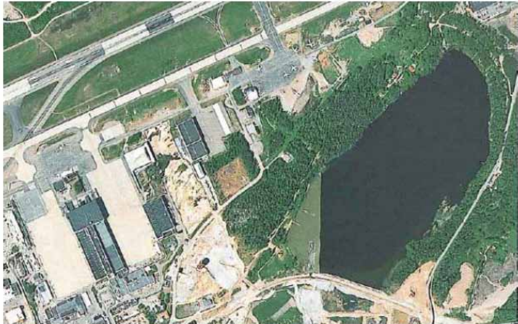
Figur 7.73. Flygbild i samband med byggandet av ljusrampen. Grumlingen är genom geotextilgardiner begränsad till den västra delen av sjön.
