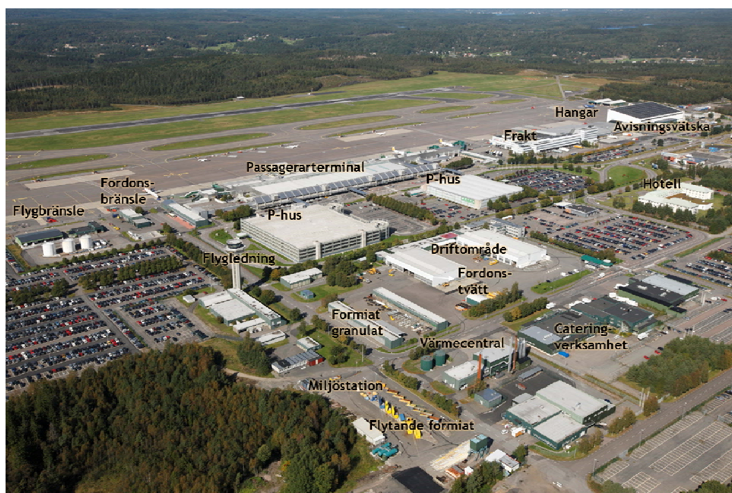
Figur 6-2. Byggnader och anläggningar inom det centrala flygplatsområdet. Källa: Swedavia
