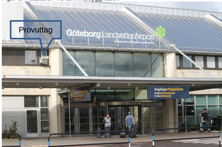
Figur 3. Mätstation vid terminalbyggnaden
