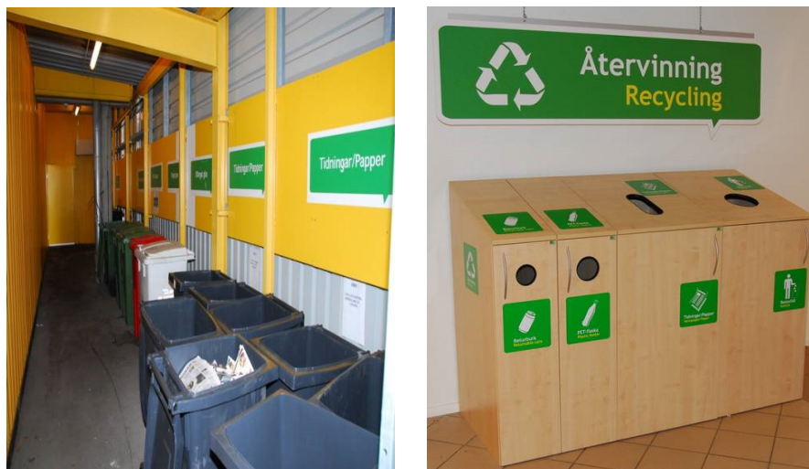
Figur 4.6 Miljöstation 2 och källsorteringsmöbel i terminalbyggnaden
