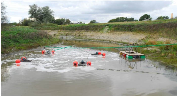
Figur 4.3 Utjämningsmagasin för dagvatten
