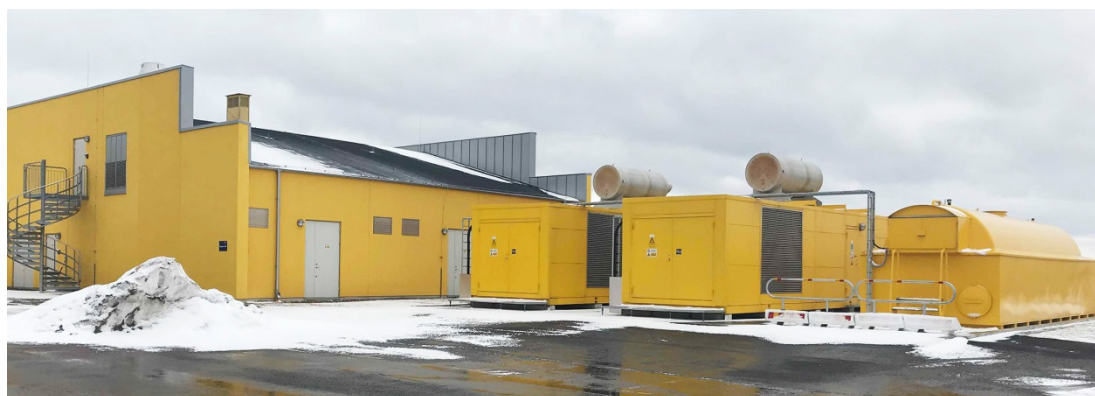
Figur 4.2 K50, ställverk med tillhörande reservkraftscistern.
