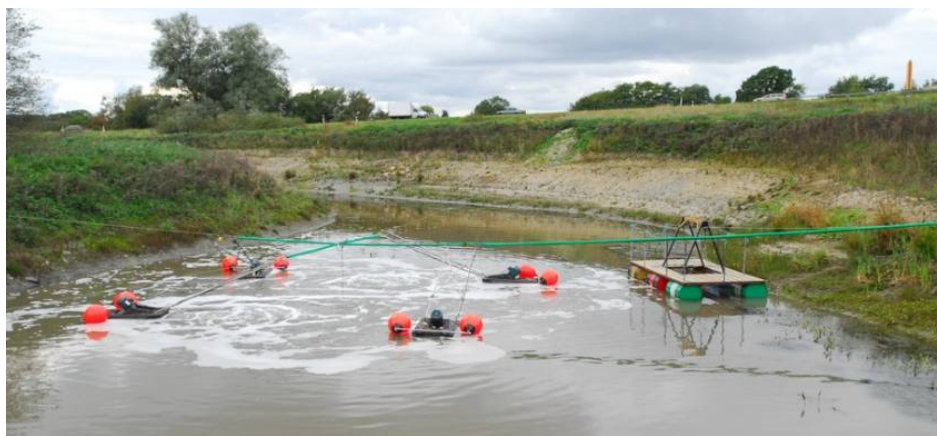
Figur 4.4 Utjämningsmagasin för dagvatten
