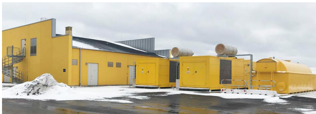
Figur 4.2 K50, ställverk med tillhörande generatorer och reservkraftscistern.
