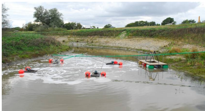
Figur 4.2 Utjämningsmagasin för dagvatten
