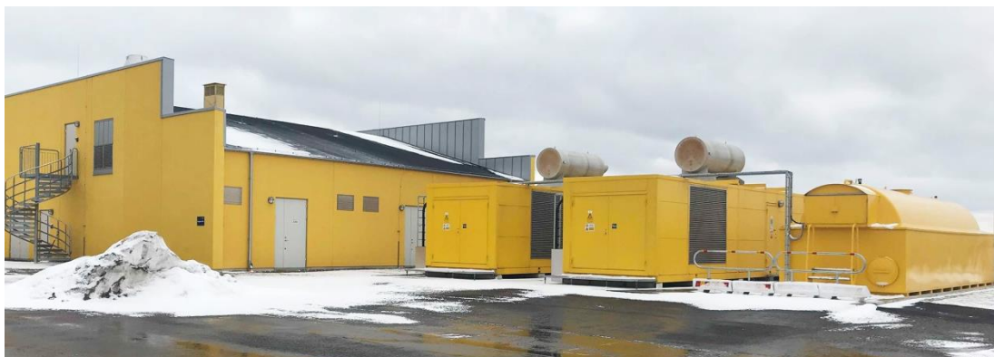
Figur 4.2 K50, ställverk med tillhörande generatorer och reservkraftscistern.
