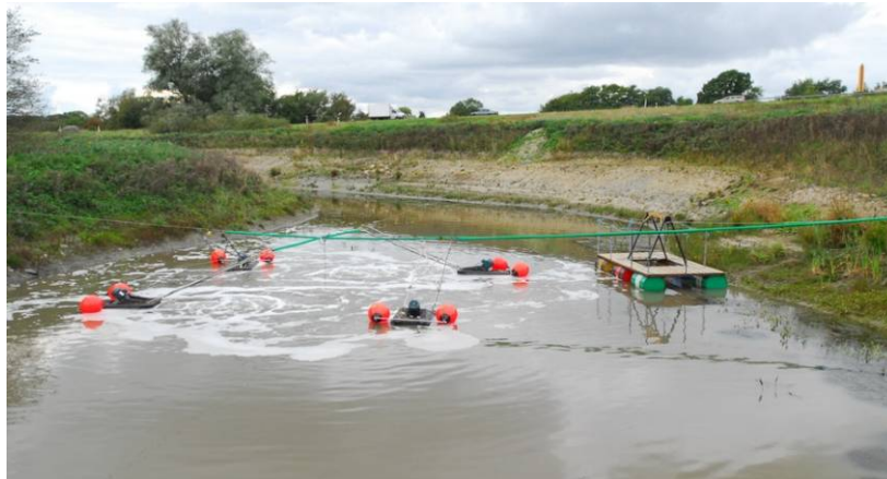
Figur 4.2 Utjämningsmagasin för dagvatten
