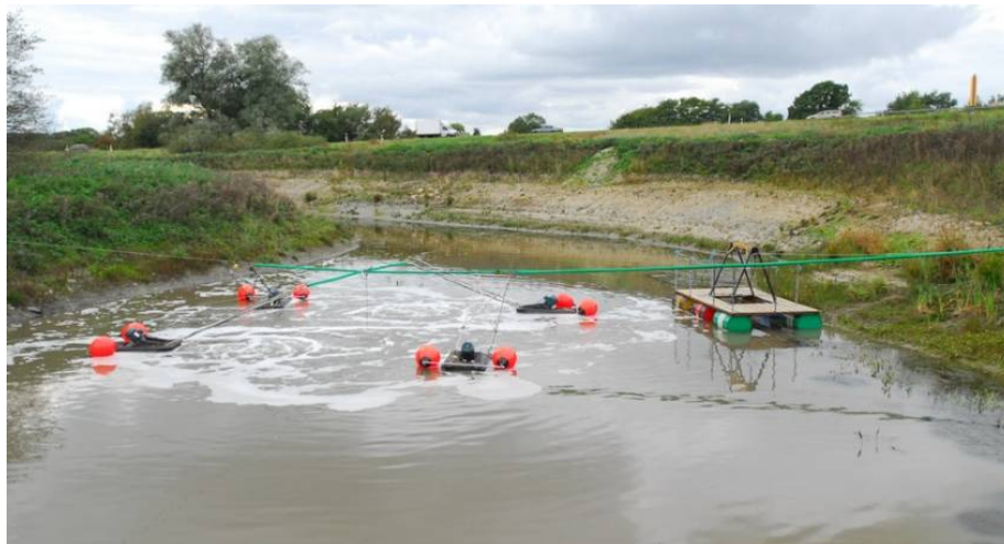
Figur 4.2 Utjämningsmagasin för dagvatten
