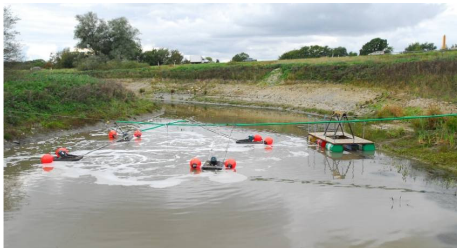
Figur 4.2 Utjämningsmagasin för dagvatten
